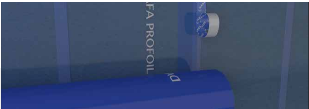
Dampspærrefolien monteres med overlæg og tapes med DAFA dampspærretape.
