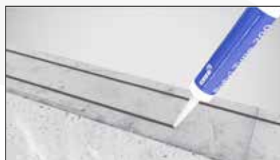
Tætning ved sokkel/fundament .
